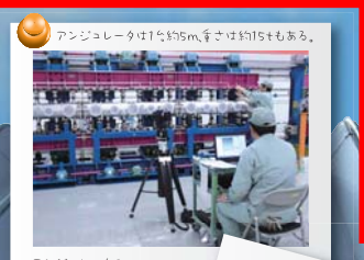
アンジュレータの据え付け作業風景
